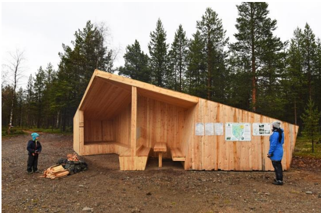
Bildet viser gapahuken ved Porten til Treriksrøysa som ble ferdig høsten 2015. Den er på ca 20 kvadrater grunnflate og med en maksimalhøyde på 3 meter. Foto: Biotope AS.
