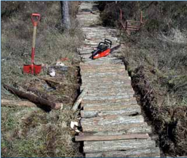
Klopplegging i Svingervann naturreservat.
