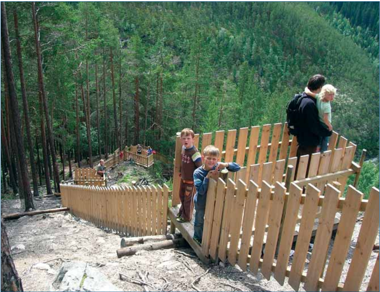
Trapper, gjerder og utkikksposter øker tilgjengeligheten for de mange besøkende samtidig som de sårbare "prestene" skjermes mot ferdsel og unødig erosjon i Kvitskriuprestinn naturminne.
