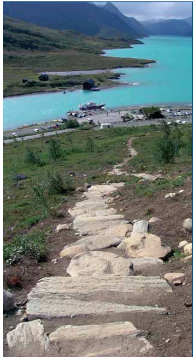
Steinsetting av sti er kostbart og arbeidskrevende, men et effektivt tiltak i slitasjutsatte områder med mye ferdsel. Her fra stien fra Gjende opp mot Besseggen ved Jotunheimen nasjonalpark.
