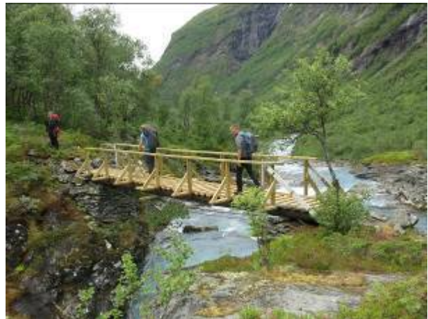
Ny stokkbru over Utla ved Vormeli
