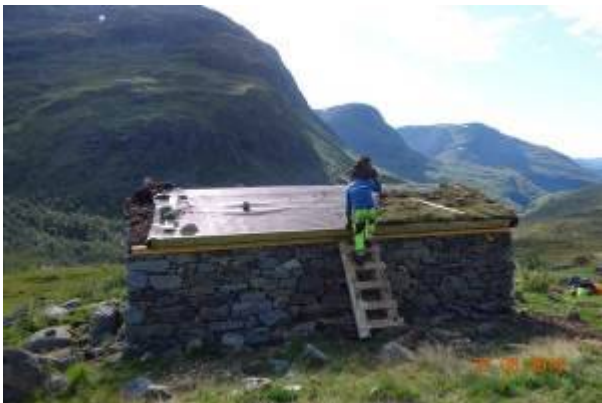
Torvtaklegging i Guridalen i august
