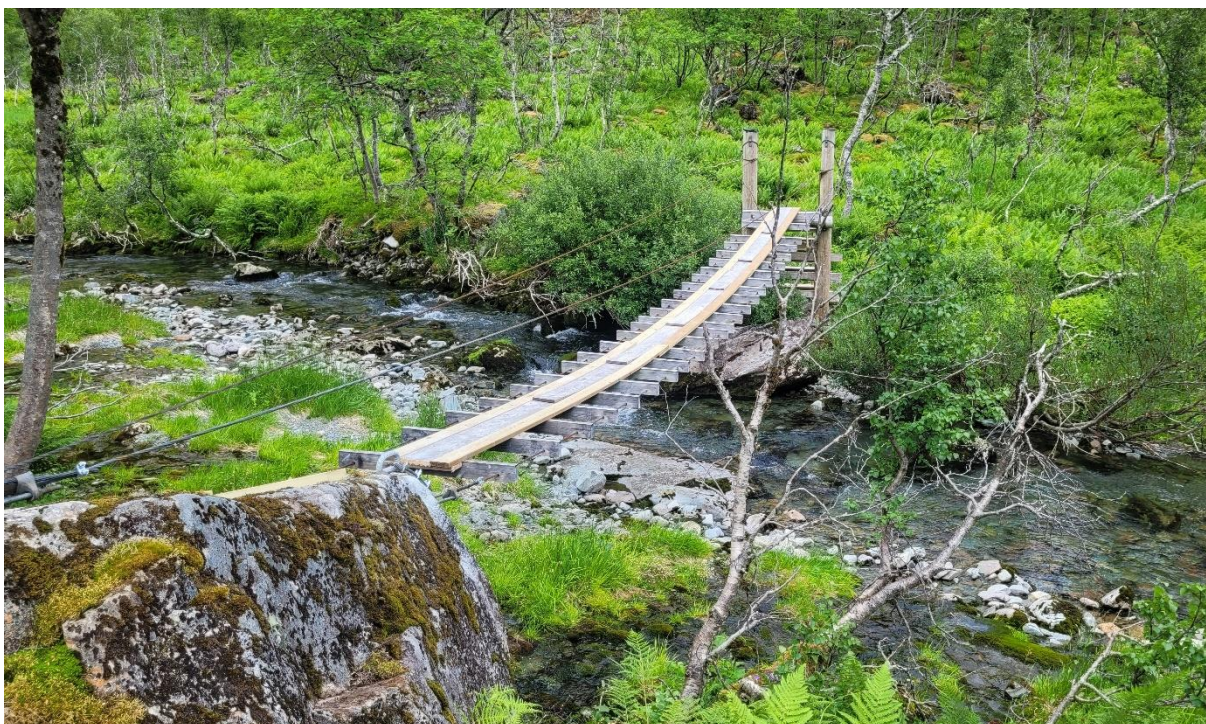
Bilete 3. Hengebrua ved Grøndalsstøylen etter utbetring.
