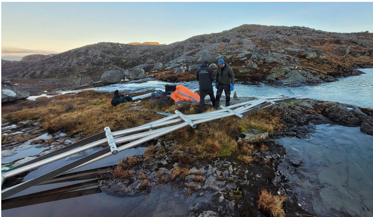
Bilete 7. Brua er løfta av og dradd på land. Vi startar reparasjon og utbygging av øydelagde delar.
