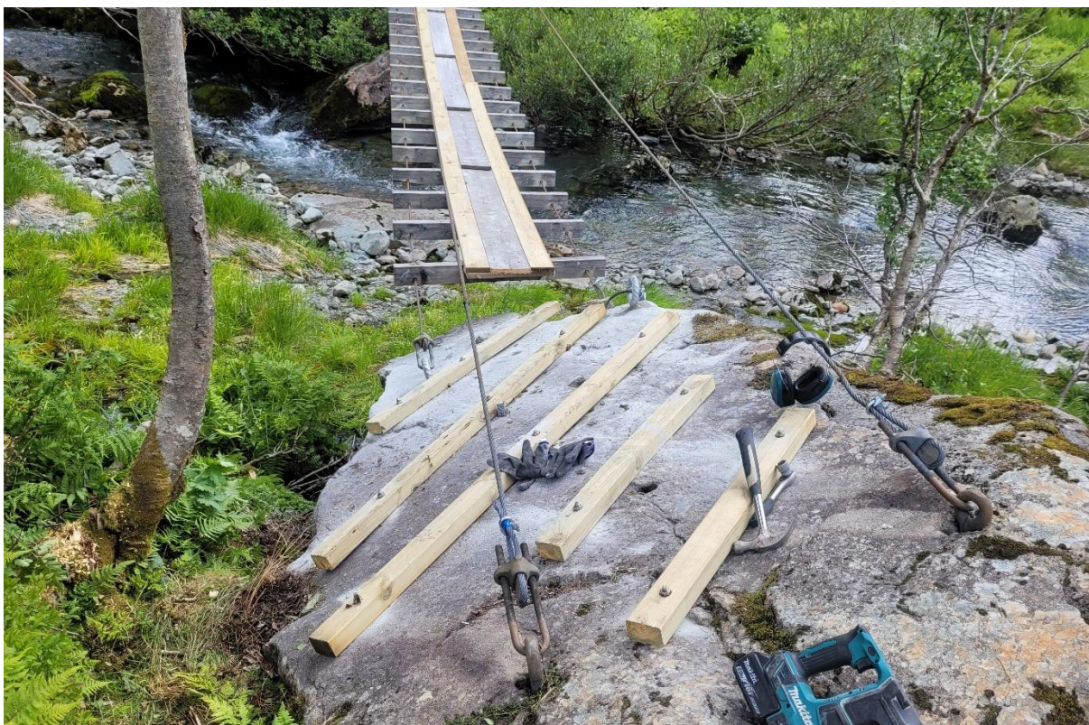
Bilete 5. Forsterka forankring og betre tilkomst på vestsida av hengebrua.
