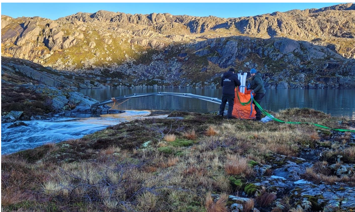
Bilete 8. Brua er reparert, forsterka og satt på plass att. Vi må tilbake våren 2025 og sette på plass rekkverk og gjere brua klar for sommarsesongen 2025.
