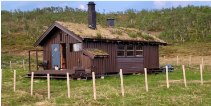
Foto av Luftsloppet
