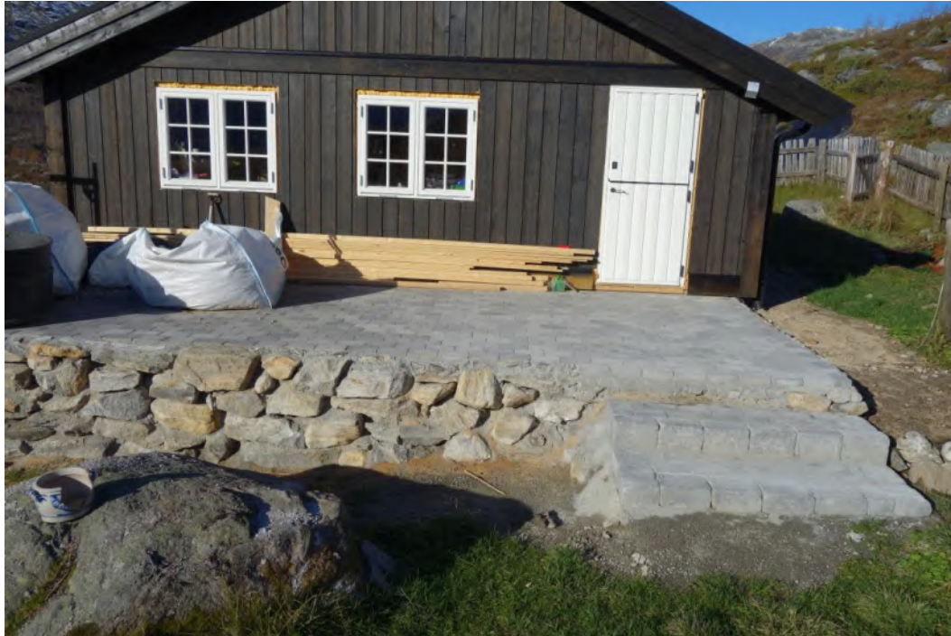
Plattingen etter ferdigstilling - detalj.
