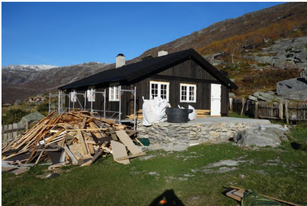
Plattingen etter ferdigstilling.
