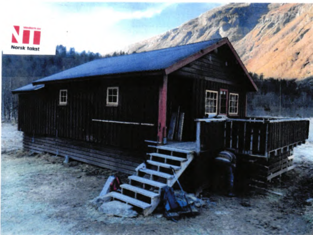
Bygningen står på pålar og golvet er trebjelkelag. Veggene er oppsett av bindingsverk, er delvis isolerte etter byggetida sine.
