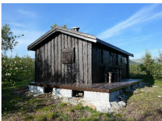
Status hytte 2015 før iverksetting av tiltak
