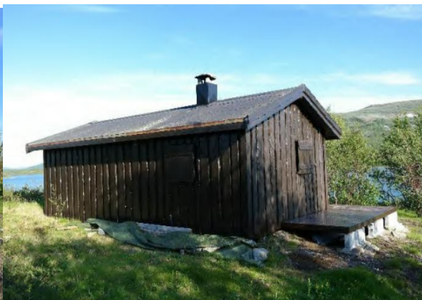
Status hytte 2015 som viser størrelse på plattning på tverrvegg
