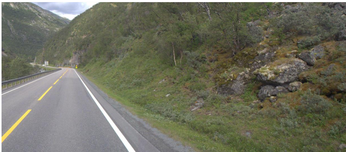
Figur 28: Bildet viser hvor muren omtrentlig vil starte, sett fra sør mot nord. Foto: Statens vegvesen
