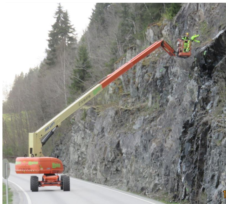
Figur 22: Eksempel på fjerning av løse partier fra veg. Foto: Statens vegvesen.
