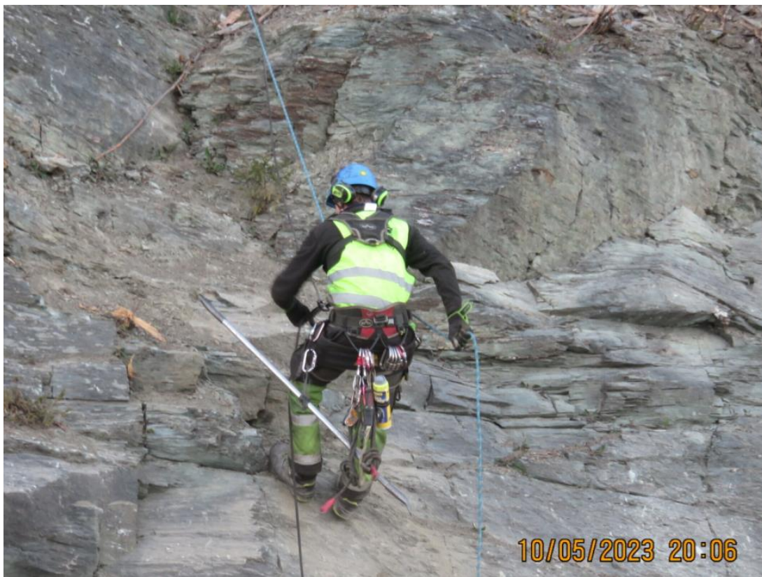
Figur 23: Eksempel på spettrensk fra tau. Foto: Statens vegvesen.
