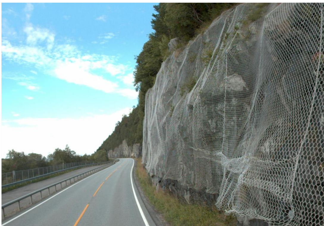
Figur 24: Eksempel på ferdig montert is-nett. Foto: Statens vegvesen
