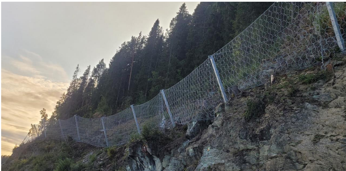
Figur 21: Eksempel på ferdigmontert fanggjerd, fra Vegvesenets prosjekt E6 Langnesberga. Foto: Statens vegvesen.
