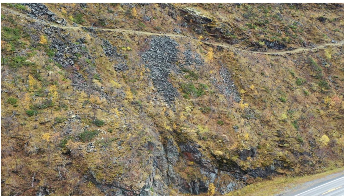
Figur 6: Eksempel på løse steiner, fra Vårstigen og E6 ca midt i tiltaksområdet. Foto: Statens vegvesen
