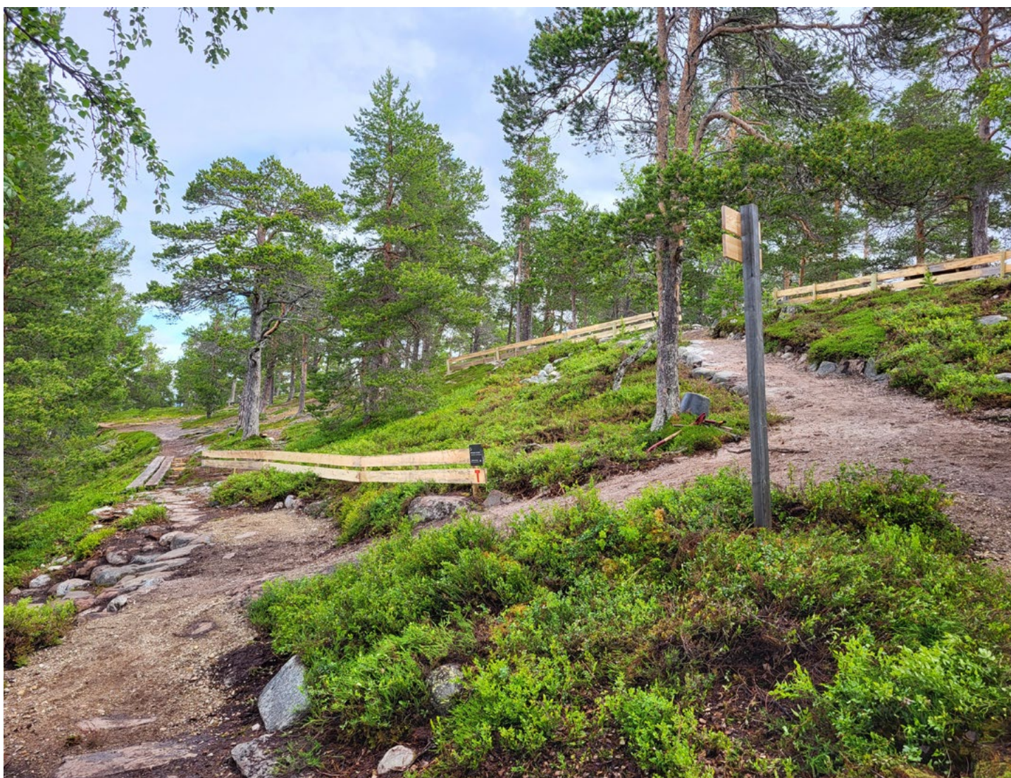
Ved brygga på Røosen har den gamle steintrappa blitt fjernet og området er revegetert. Stien ble lagt om og gruset for å unngå mer slitasje. Foto: Sindre Kolstad Valan
