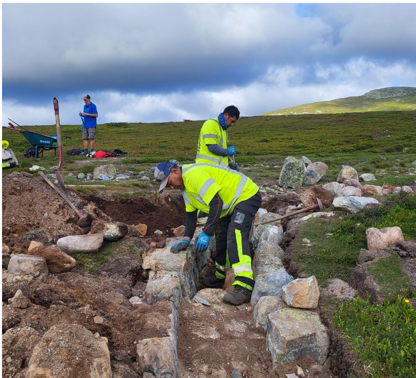
Sherpaer fra Nepal bygde 15 vassrenner av stein langs Linnéstien, for å lede vann ut av stien og hindre erosjon. Foto: Sindre Kolstad Valan
