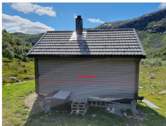
Taket ved kontroll i 2022
