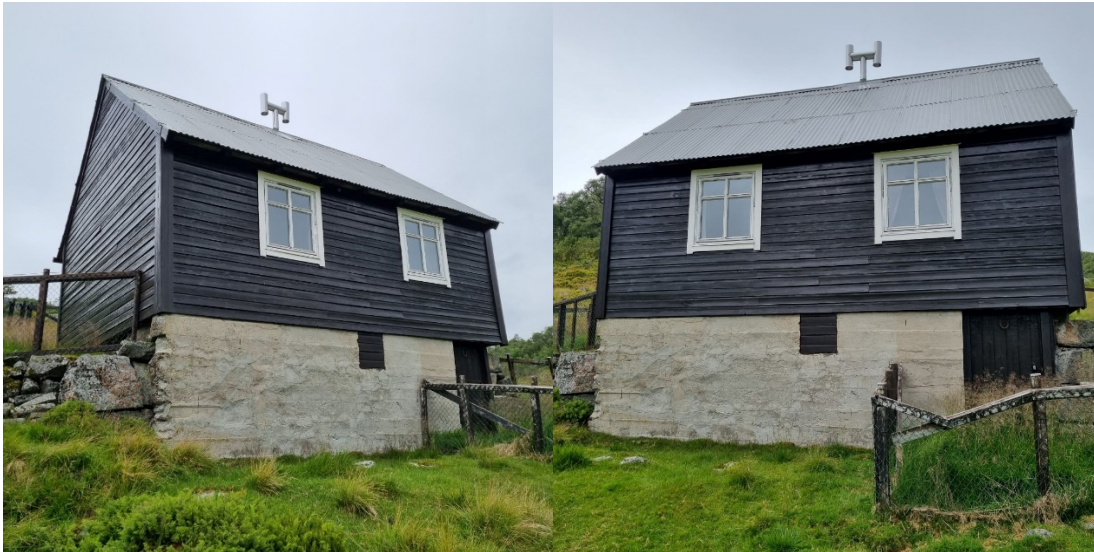
Figur 6: Nabolag med grunnmur i betong
