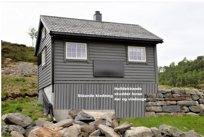
Figur 1: Tiltak sørveggen av muren
