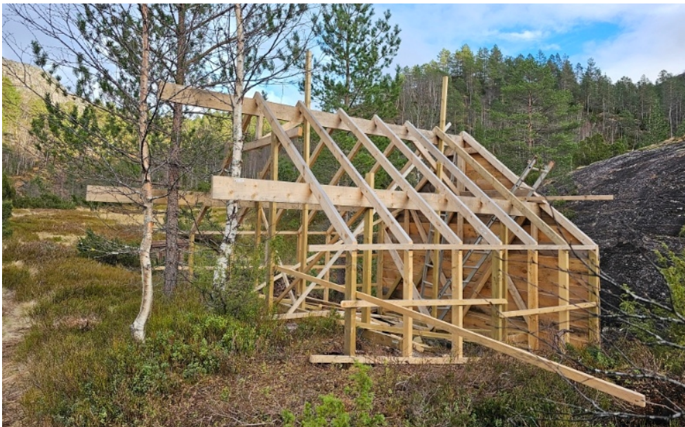
Figur 1. Boda slik den står i dag. Arbeidet vart starta tidlegare i år, men er no satt på vent. Ytre mål: 4 meter x 4,4 meter med ei mønehøgde på 3 meter, sideveggar med ei høgde på 1,4 meter
