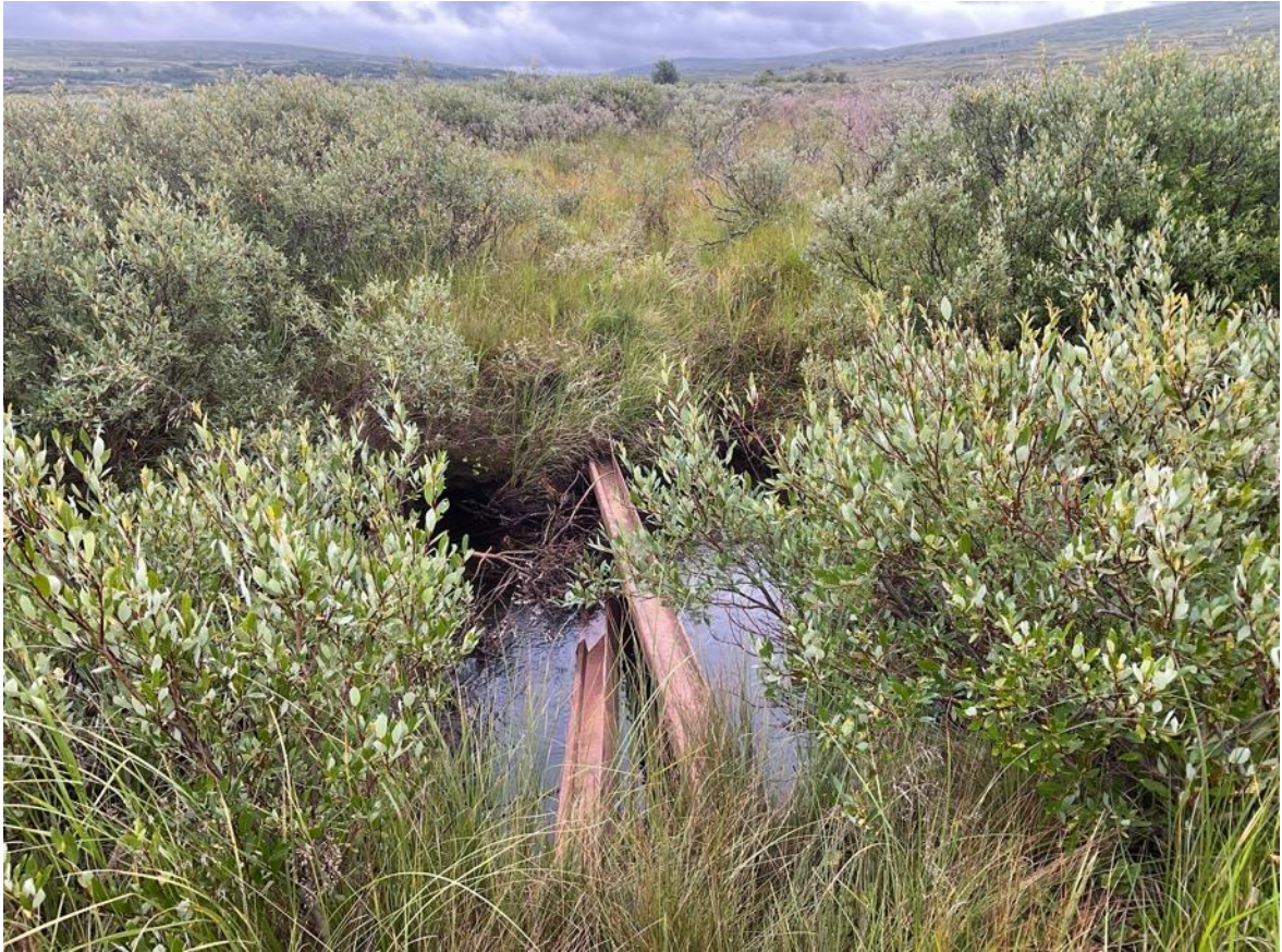
Figur 20. Ei bru har falt sammen og hindrer beitedyr i å bevege seg rundt på vestre side av Ya. Broa bør settes i stand for å bedre forholdene for beiting. Bildet viser også den sterke gjengroingen og at det kun er en sti av intakt eng igjen. Foto Sylvelin Tellnes.
