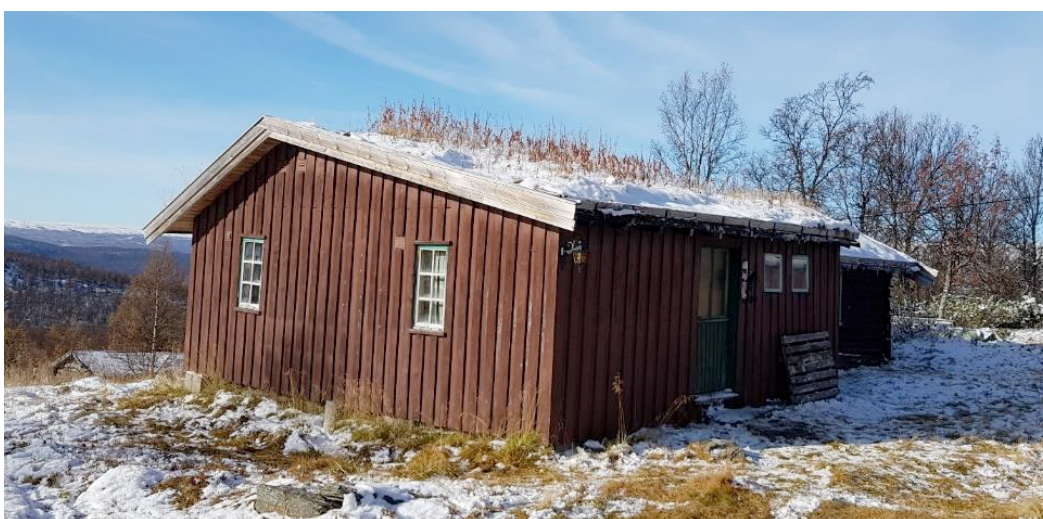
Figur 3: Eksisterende hytte, nord-øst
