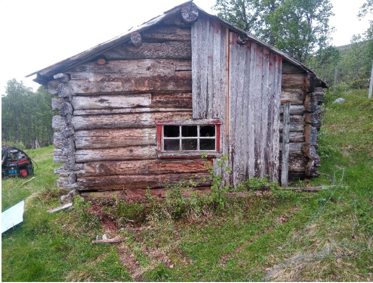
Bilde 1 – gavlvegg mot nord
