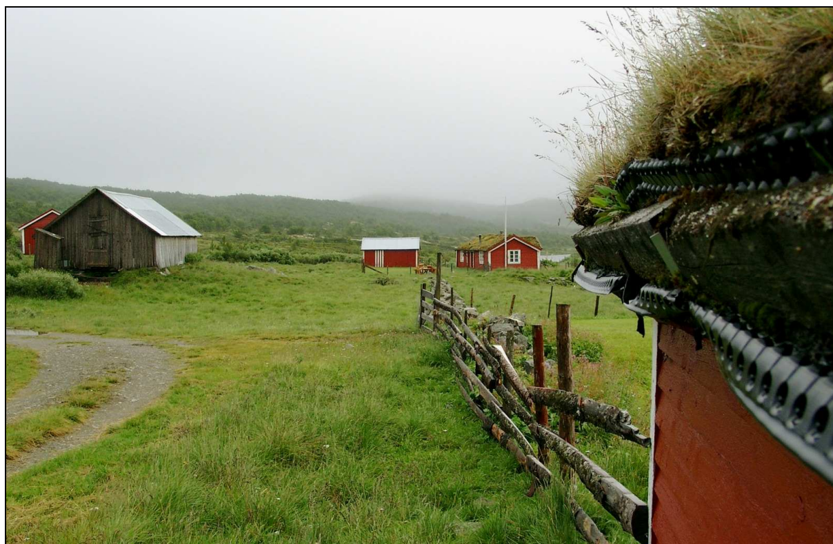
Figur 22. På Meiåvollan står mange godt bevarte seterstuer med tilhørende uthus, her et parti fra den nederste vollen. Bygningen er satt i stand i pakt med tradisjonell byggeskikk, og setra framstår som en bevaringsverdig helhet.
