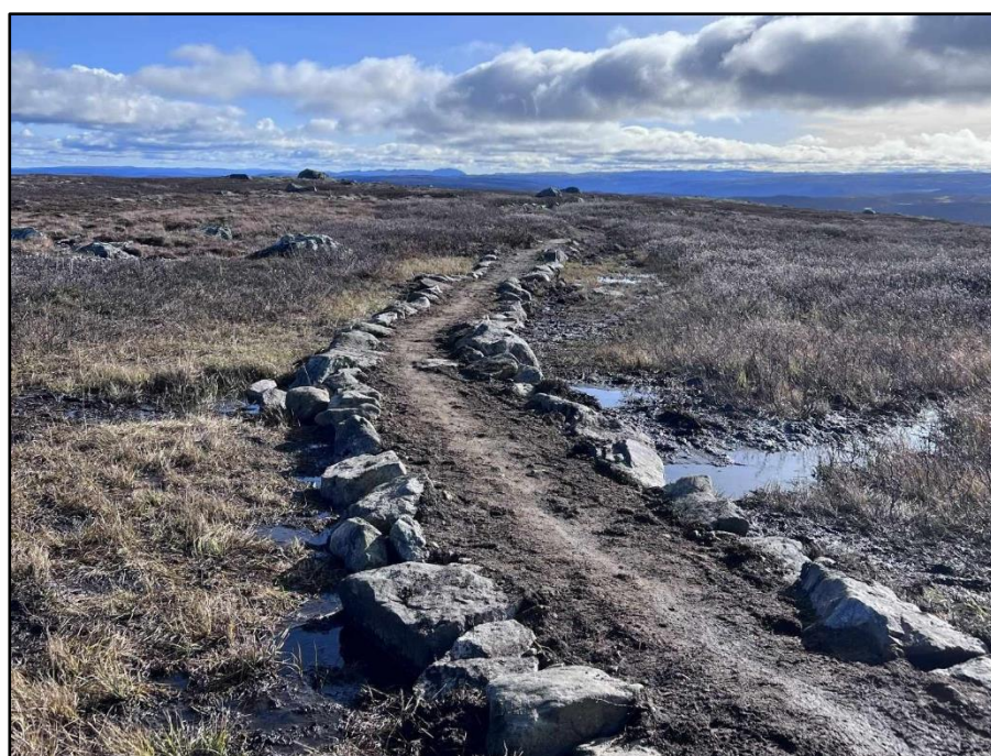
Myrpartiet mellom Urundberget og Geilohovda er utbedret (2023).
