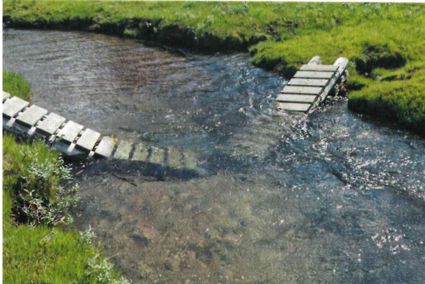
Figur 1 Noverande bru, slik den låg 23.07.2023
