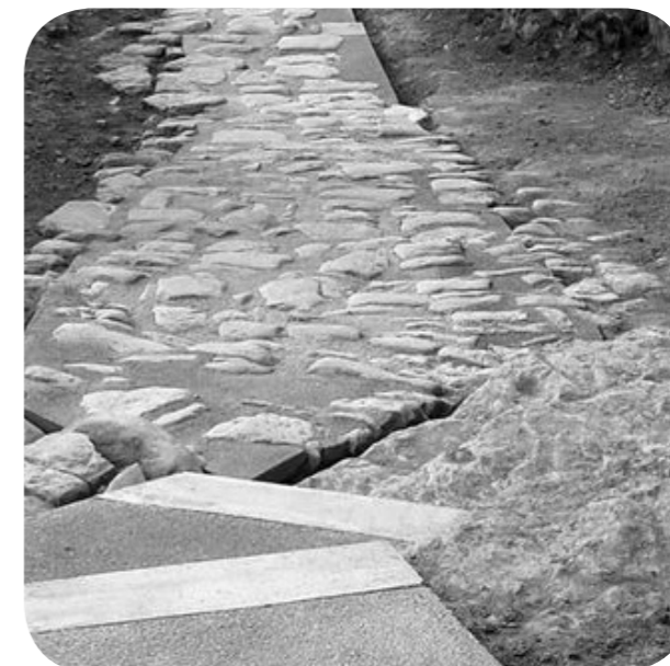
6 Lokal stein med støpt betong
