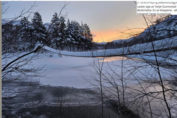
05.01.25 Deltateprosjektet - kjøring av vei - maling av bru 04.jpg Lastet opp av Tarjei Gunnestad Beskrivelse: Brua over Kvamhængselva Fotograf: Tarjei Gunnestad
