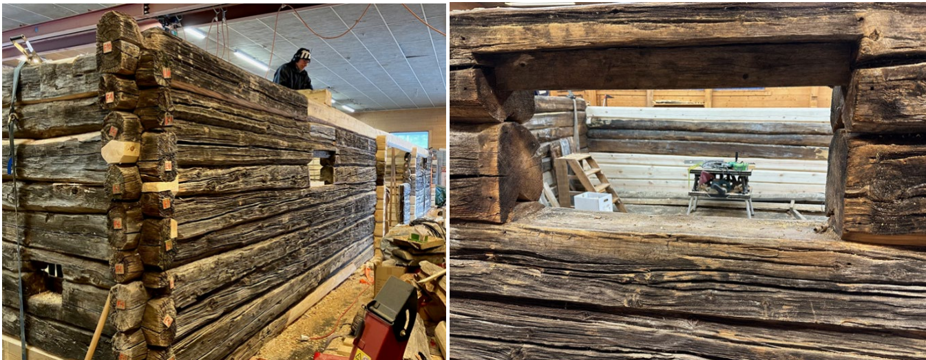
Bildene viser gjenoppbygging av 1. et i laftehallen.
