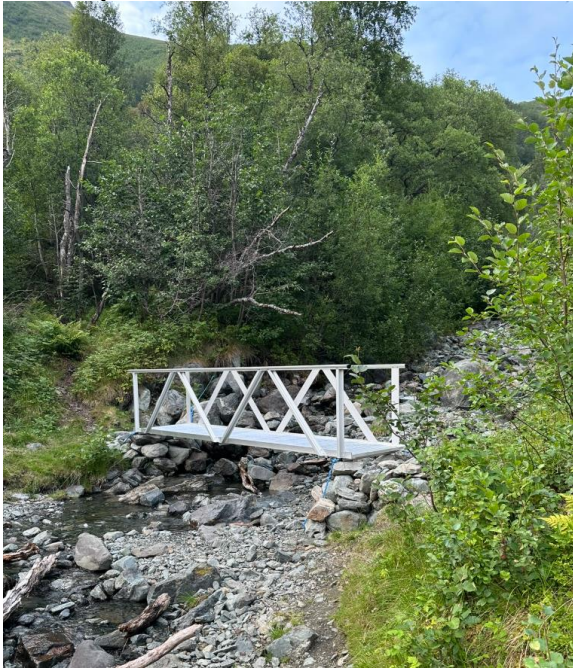
Den nye brua
