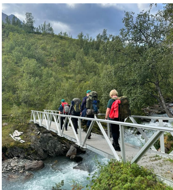
På den nye brua som styret har bekostet
