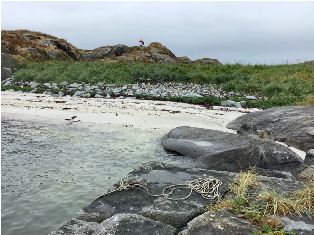
Figur 38. Den steinmurte havna sett fra sør mot nord. Det er også murt kai i den nordlige delen. Sandynen er forbygget med stein. På toppen går det en steinlagt vei mellom vestlig og østlig del av holmen. Foto: Pål Alvereng
