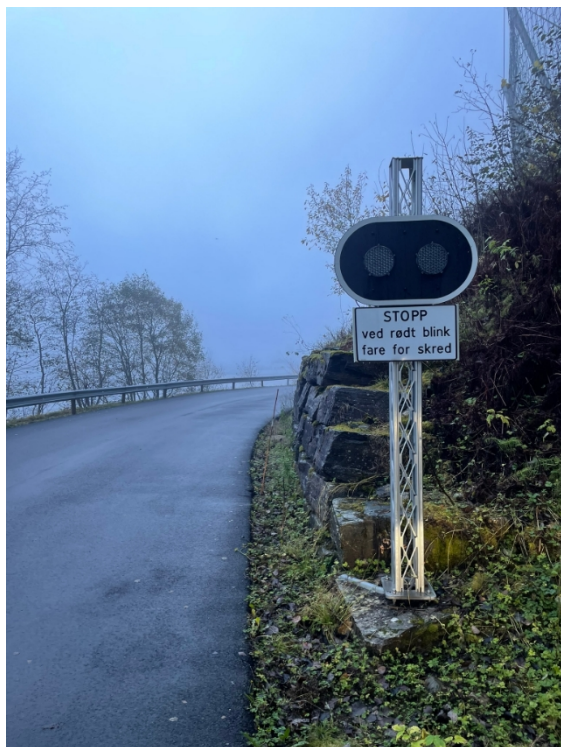
Figur 5 Stopplys ved tunellen, retning Gudvangen. Kjelde: Søknad frå fylkeskommunen
