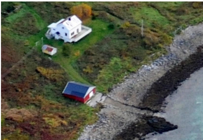
Bilde 1: skråbilde av bygningsmasse på eiendom 5534-26/4 fra 2009.
