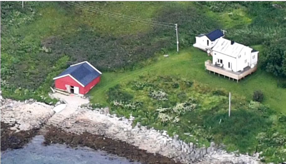
Bilde 2: skråbilde av bygningsmasse på eiendom 5534-26/4 fra 2020
