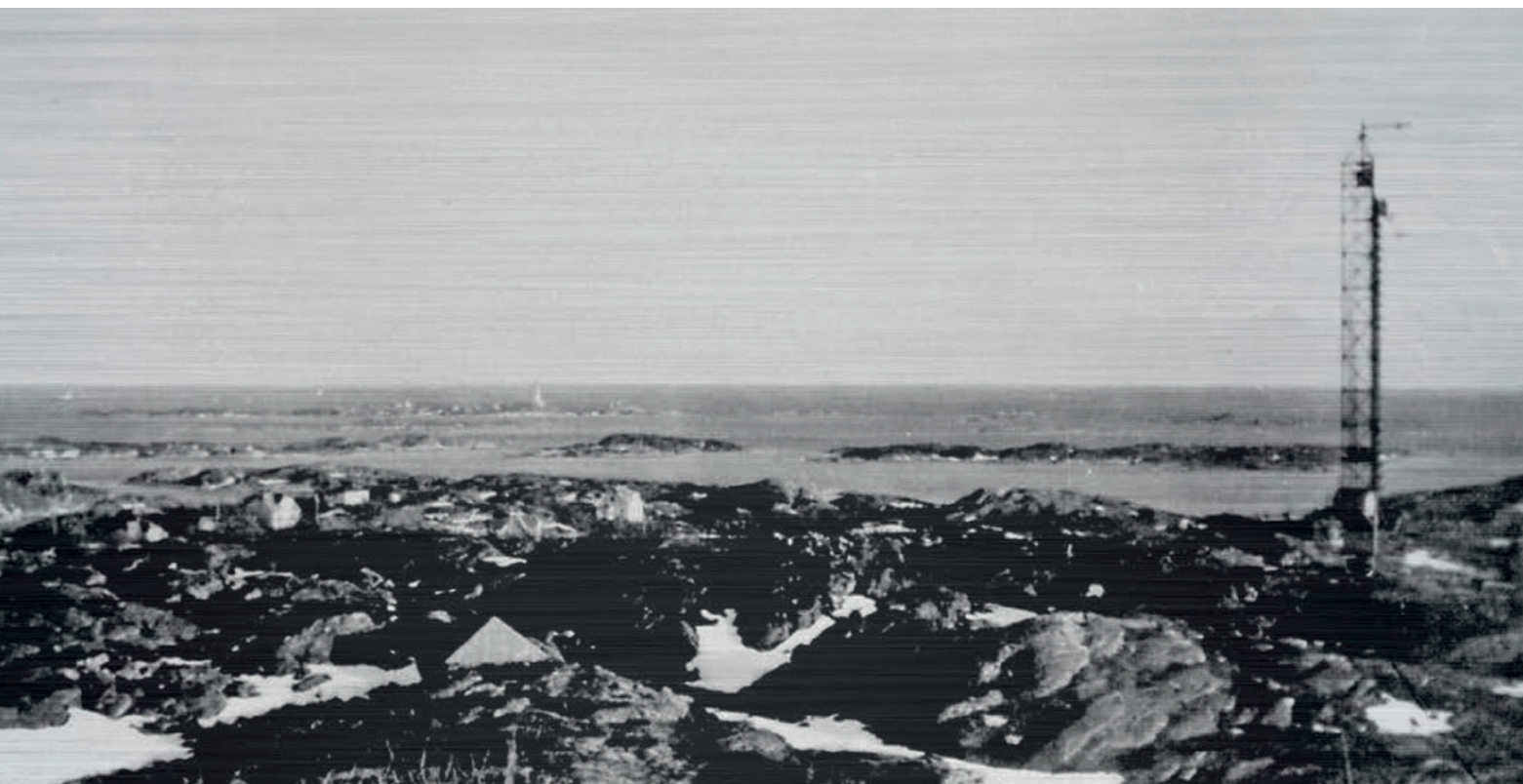
Radarmasta på Høyfjell av typen Wassermann MII, ble utviklet og bygget av Siemens fra 1942 for okkupasjonsmakten. Radarmasta var i følge kildene 40 m høy, pluss et fundament som antakelig var rundt fem meter høyt. Foto via Rolf Bakken
