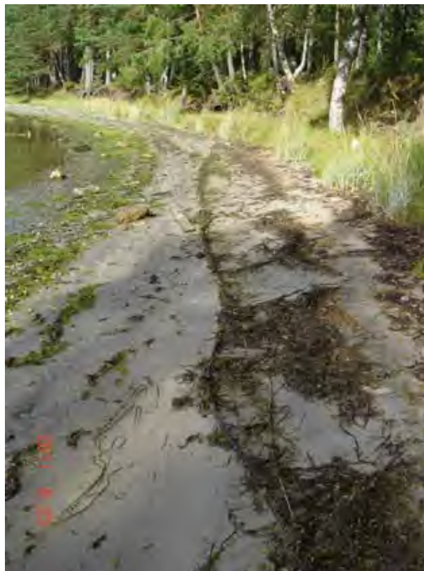
Figur 131: Plastledning ute av bruk som bør fjernes.
