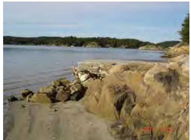
Figur 128: Fjerne rester av betongkonstruksjoner. Tiltak 5-10. Foto: Karin Guttormsen
