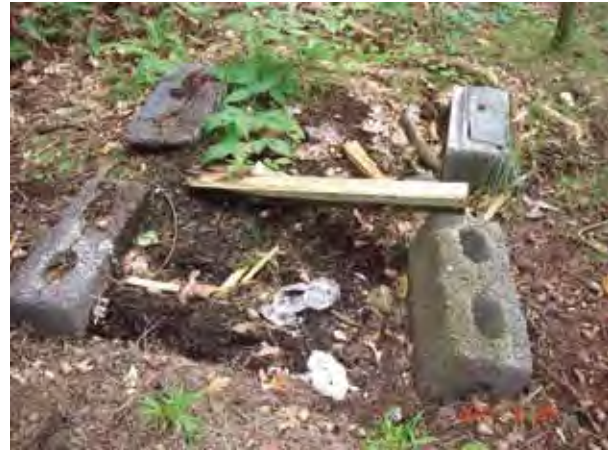
Figur 127 b: Bygningsrester (utedo) for tidligere Sneglehuset fjernes. Tiltak 5-9. Foto: Karin Guttormsen
