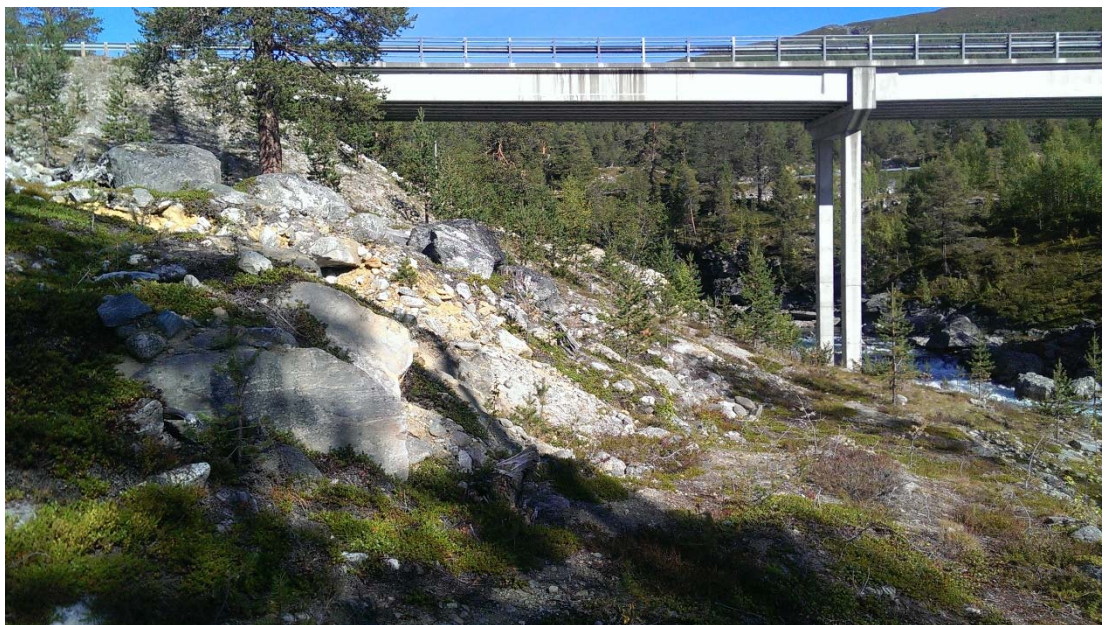
Terrenget ligg godt til rette for GSV på både sidene av brua.
