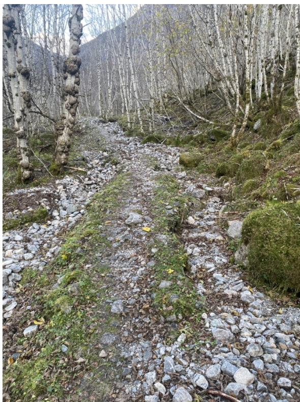
Sti nedanfor brua der store deler av stien er øydelagt av vann. Stien manglar stikkrenner slik at ved store vannmasser tar vatnet stien som bekkedar. Foto: Mari Melbø Rødstøl
