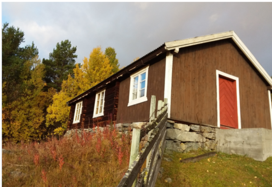
Bilde 1: Bildet viser betongtrapp ved inngang på selet. Det søkes om å legge gulv på trapp som forlenges "rundt hjørnet". Trappetrinn ned til terrengnivå der det legges treplattung.
