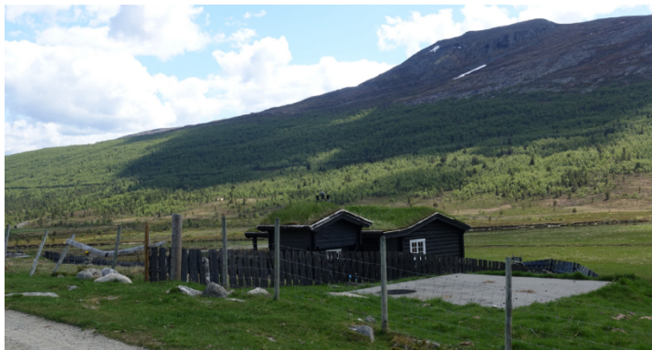
Foto: Støypt fundament der Klomsrohuset skal plasserast.
