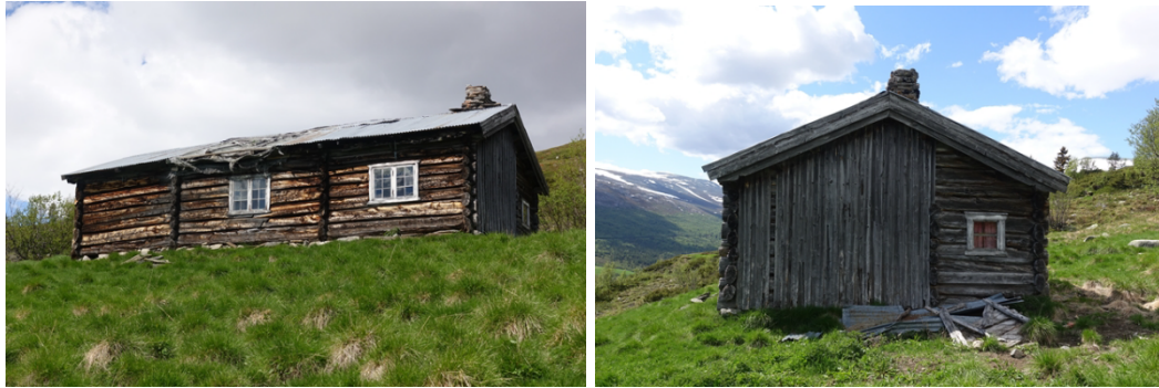
Foto: Klomsrohuset som skal restaureres og byggast på med skuti.
