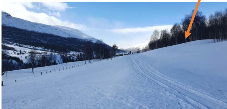
Plassering av mast med kamera inntil vegen, og solcelleanlegg med teknisk skåp på innsida av vegen, inn mot vegetasjon/skog.
