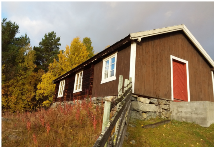
Bilde 1: Bildet viser betongtrapp ved inngang på selet. Det søkes om å legge gulv på trapp som forlenges "rundt hjørnet". Trappetrinn ned til terrengnivå der det legges treplattung.
