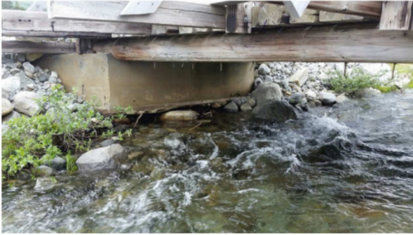
Figur 5-9 Undergraving av det ene fundamentet til Traversbrua (Foto fra søknad fra setereigere på Vangen).
