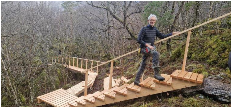
Svein Roger Ivarsen i Ny Sti AS som fristiller trappa ved Eiafossen.
