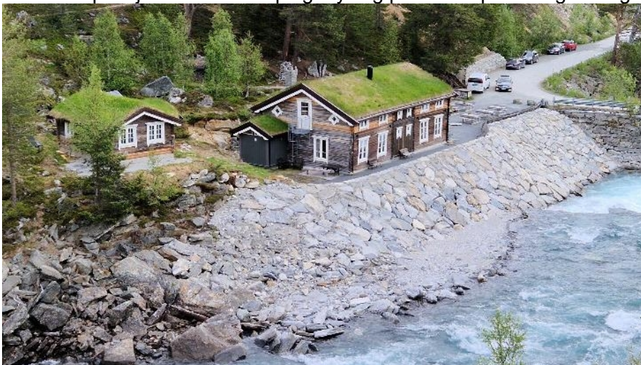
Sikringsmur mot Tora elv
