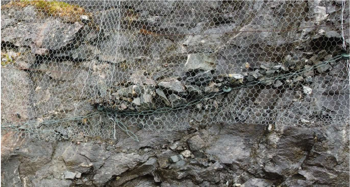
Bilde 9: Dronebilder av eksisterende sikringsnett
