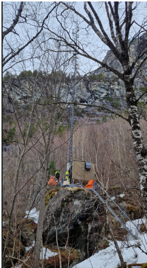
Foto av eksisterandele mast t.v.
