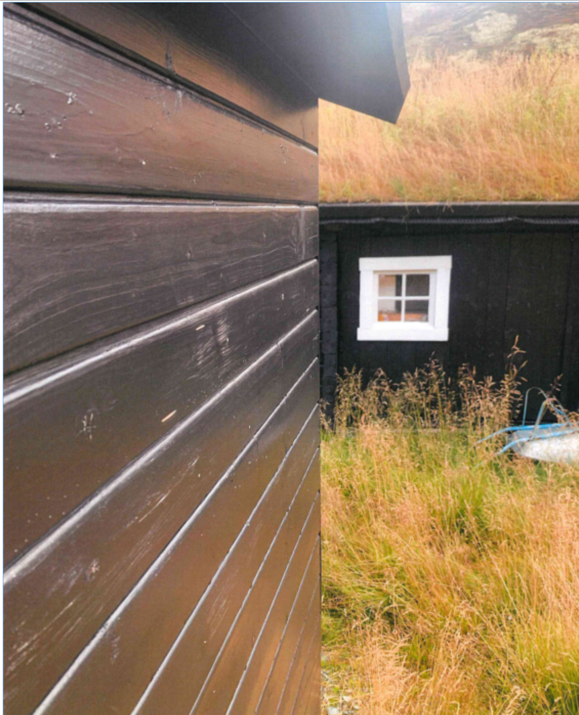
Figur 8. Bilde av uthuset det søkes om godkjenning for. (Fra Ola Korsvolls søknad)
