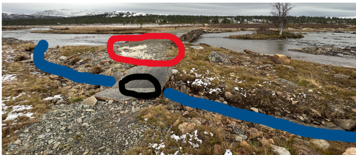
Figur Tiltak på østsida av brua.
