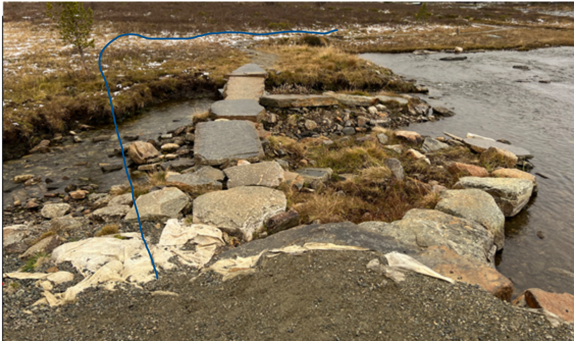
Fig. 6 Tiltak på vestsida av brua
