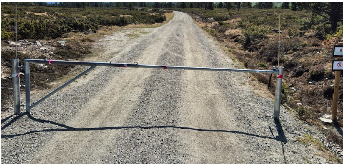
Figur 4. Type vegbom som er planlagt satt opp på Peer Gynt seterveg, sørlige del av Frydalen landskapsvernområde.
