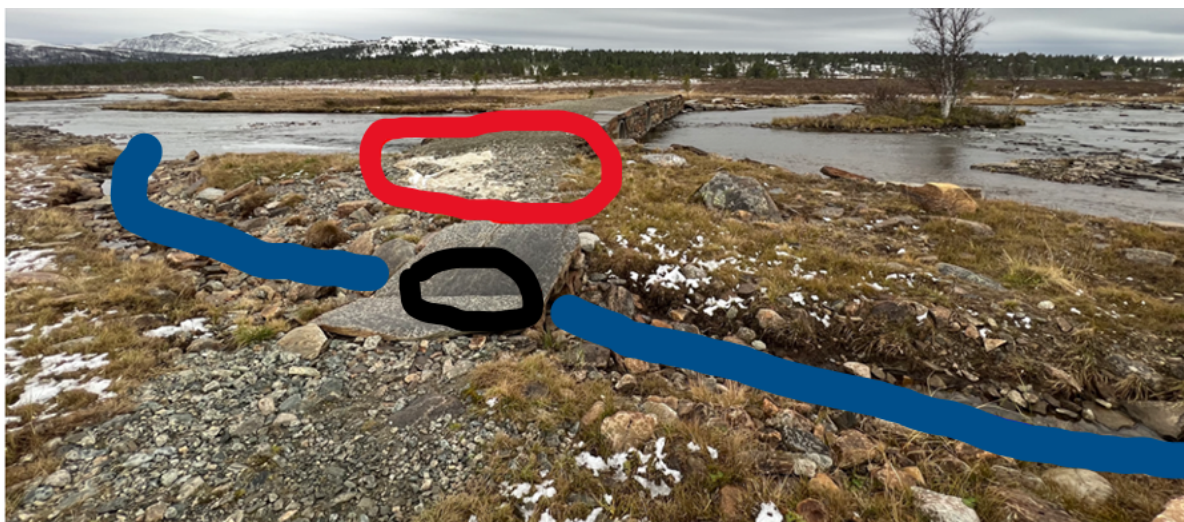
Fig. 5 Tiltak på østsida av brua
