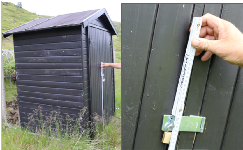
Figur 1. Senke takhøyden (møne) til 1,35 m over bakken. (Målestokken vise høyde 1,2 m over bakken)
