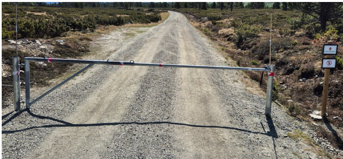
Figur 4. Type vegbom som er planlagt satt opp på Peer Gynt seterveg, sørlige del av Frydalen landskapsvernområde.
