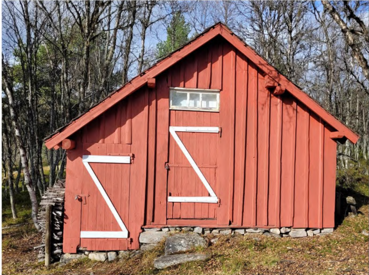
Figur 3: Eksisterende uthus sett fra sør, bilde fra søknad.
