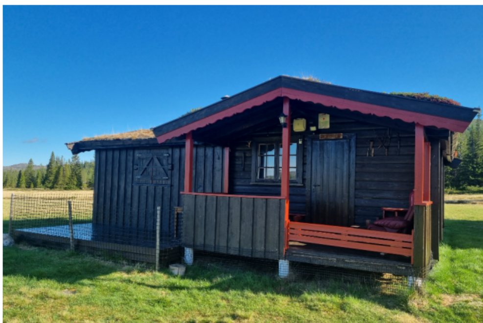
Dagens veranda/takutstikk på setersjøli på Stormoen, Midtre Roltdalen 143. Denne verandaen kles igjen og erstattes med en tilsvarende veranda. Vindu og dør flyttes ut. Foto: Slettom 2024.
