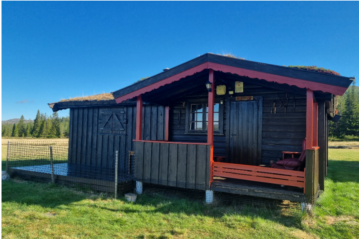
Dagens veranda/takutstikk på setersjøl på Stormoen, Midtre Roltdalen 143. Denne verandaen kles igjen og erstattes med en tilsvarende veranda. Vindu og dør flyttes ut. Foto: Slettom 2024.
