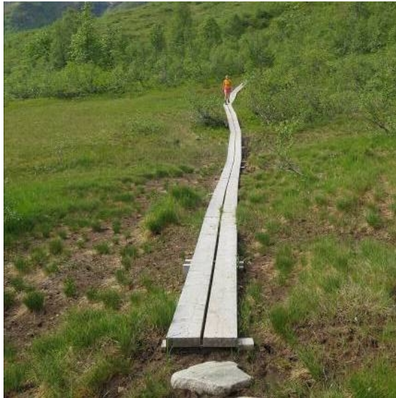
Tilrettelegging med stein og treklopper på stien mellom Steinslandstølen og Solrenningane. Foto Anbjørg Nornes
