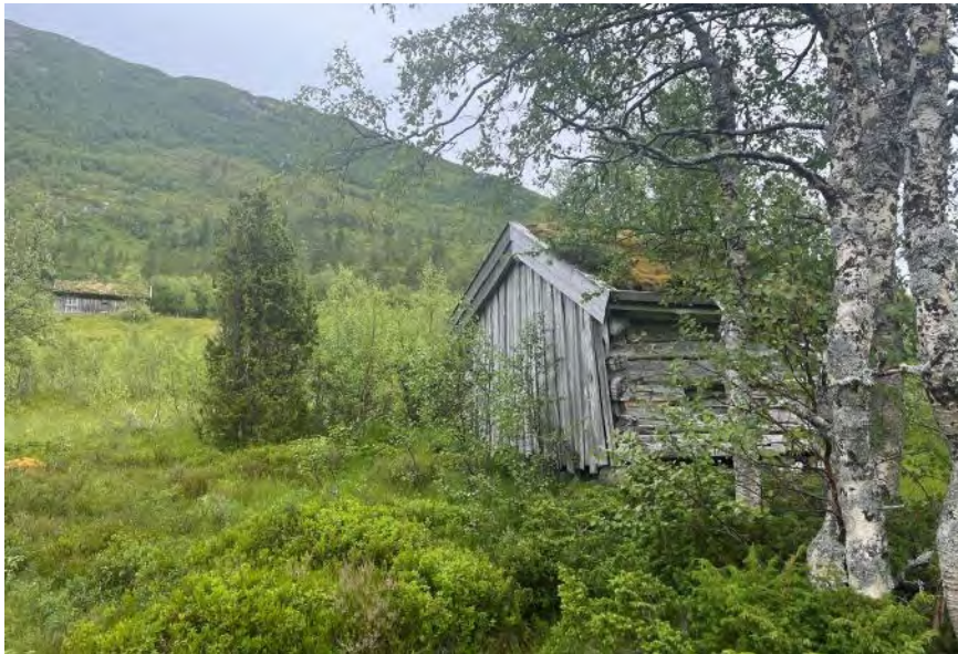
Figur 21 Den gamle høyløa til Ramsøysetra, med setra i bakgrunnen. Her kan det med fordel åpnes opp.
