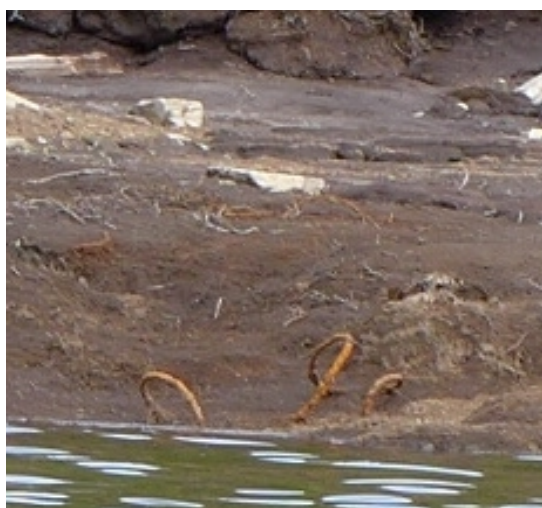
3. Vann 4, ned for brua ved vann
