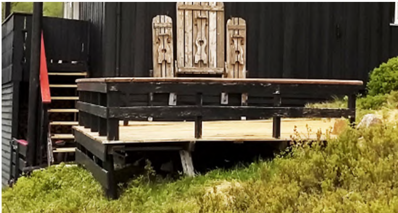
Veranda(ene) sør og vestside 28.05.2019, verneområdeforvaltningen
