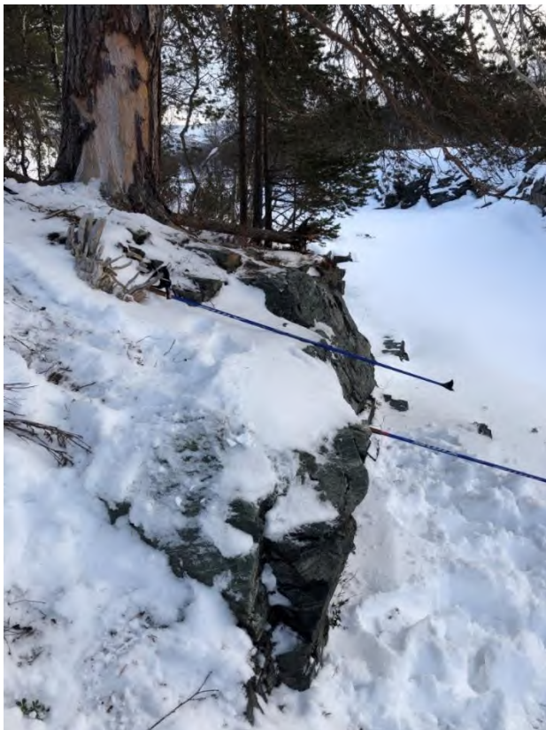
Figur 7. Bilde som viser skråningen bak fjellhylla på nordsida.
