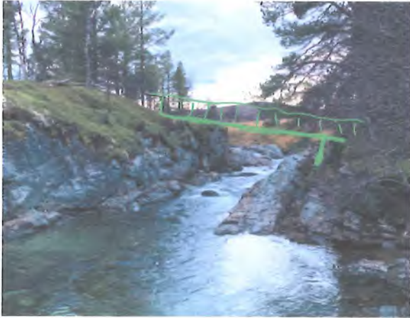
Figur 6 Brua inntegnet, sett nedstrøms
