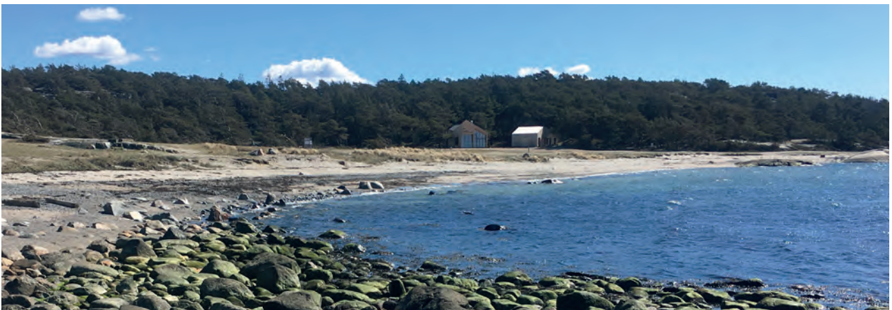
Storesand med besøkssenteret, som sto ferdig i 2021. Det erstattet et gammelt og utdatert servicebygg. Med sine flotte bademuligheter, teltslette, kystfuruskog og kulturminner trekker stedet mye mennesker og krever høy grad av tilrettelegging. Foto: Lars Ole Klavestad.
