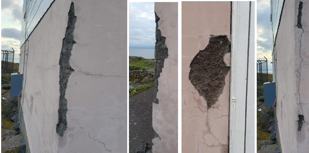
Utbedret frostskader i pussen på grunnmur og malt grunnmur
